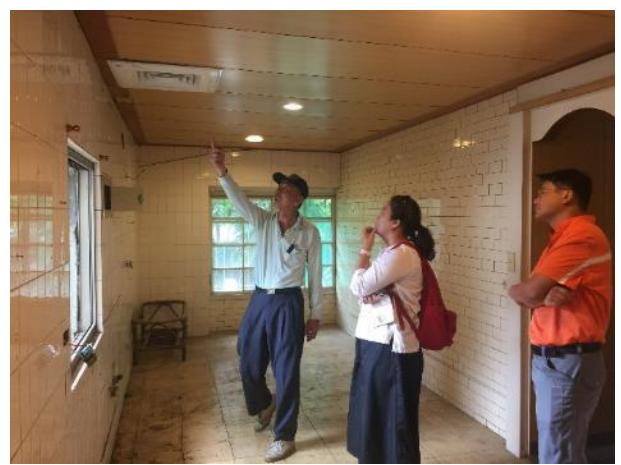
108/05/17 復水復電確認
