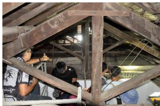
賴福林老師解說日式宿舍桁架構法
