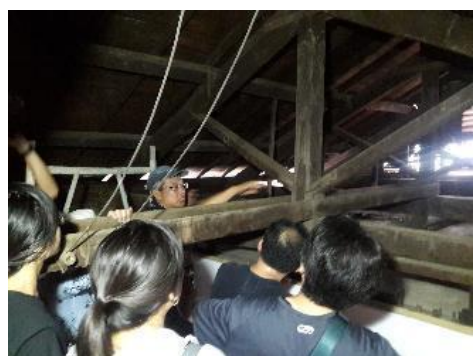
賴福林老師解說日式宿舍桁架構法
