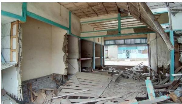
說明：盤點過程發現木構造被大肆盜取
